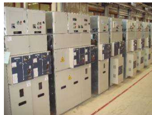
Высоковольтные линии (225 кВ), высоковольтные распределительные щиты
