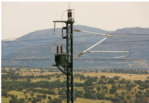
Контактная сеть 15кВ – 25кВ – 2 x 25кВ Переменного тока
