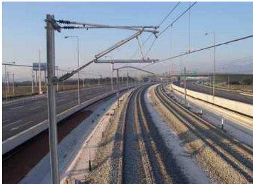
Контактная сеть 15кВ – 25кВ – 2 x 25кВ Переменного тока
